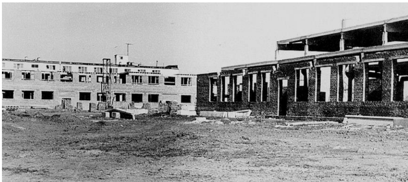
Строительство производственных мастерских. Фото 1960-х годов, п. Ахтырский. Личный архив А.В. Трубицына.
