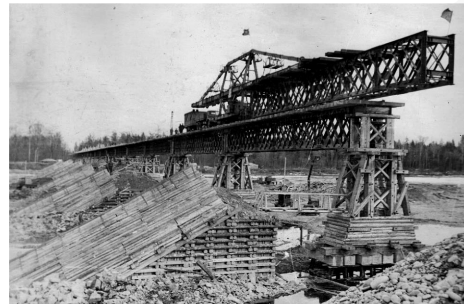
Строительстве моста через реку Бурья. Фото 1970-е годы. Личный архив В.А. Зайцева.
